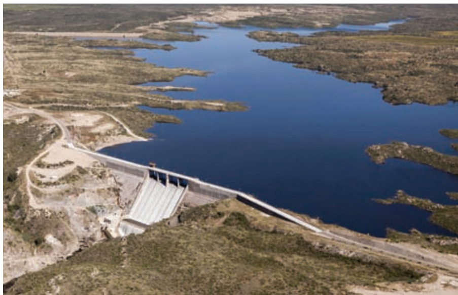
Presas sobre Rio Quinto, provincia de San Luis. Obra finalizada en 2011.
