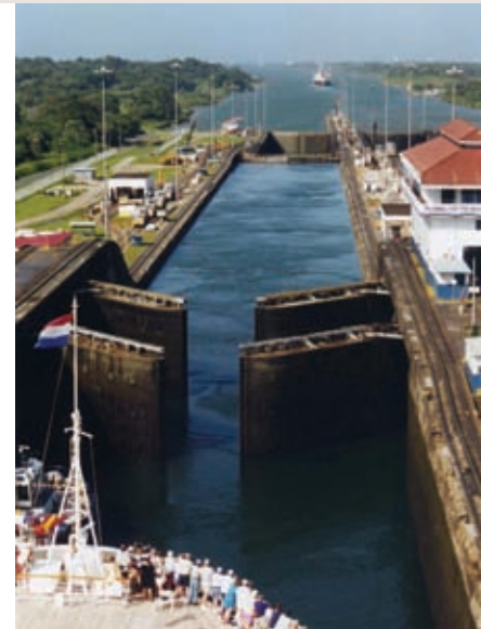
Las obras fueron paralizadas por el consorcio a cargo del proyecto el 5 de febrero.
