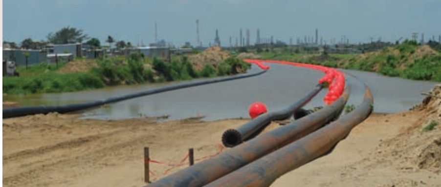
Arendal construiu um canal para manter, momentaneamente, o duto marinho de 1.480 metros, antes de ser lançado ao mar.
