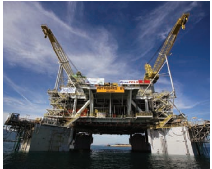
A plataforma P-61, primeira do tipo Tension Leg Wellhead Platform no Brasil, está na fase final de construção, em Angra dos Reis (RJ).
